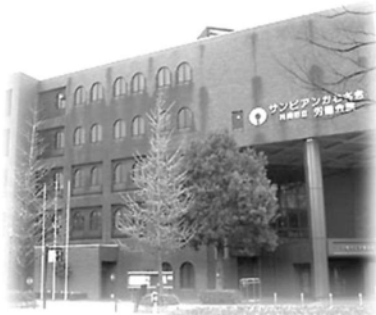
労働会館外観
