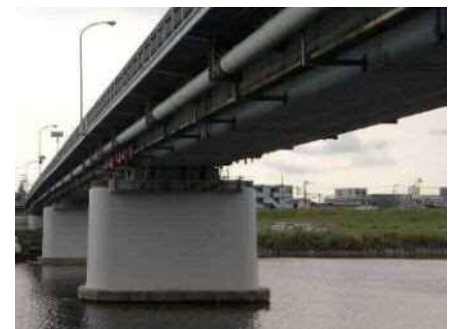
対策後（ガス橋）
