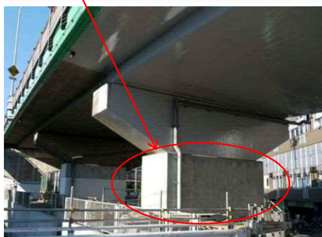
橋脚補強 (稻生跨線橋)
