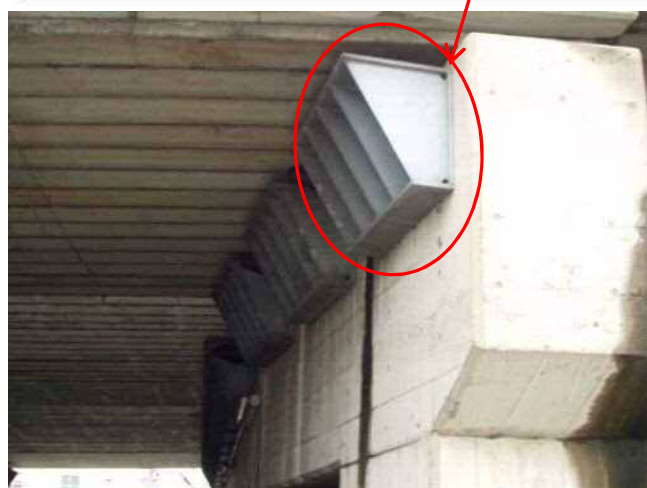
桁かかり長の確保 (塩浜陸橋)
