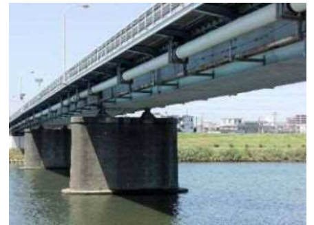
対策前（ガス橋）
