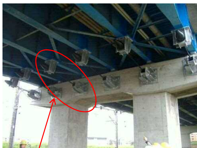
落橋防止対策 (小倉跨線橋)
