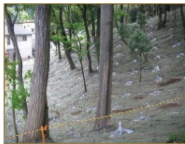
自然斜面補強土工法
