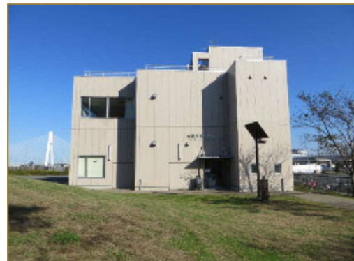
大師河原水防センター
