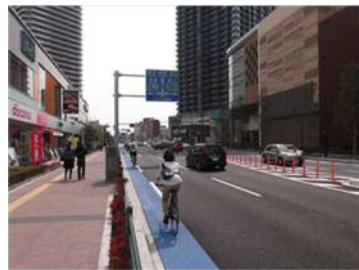
車道左端の路面を青く着色し、車道上で自転車の通行空間を視覚的に分離する自転車専用通行帯を整備。
