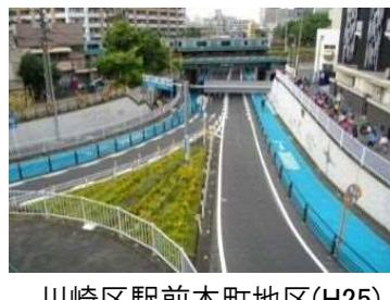
車道の間に縁石や柵を設置し、歩行者、自転車、自動車を物理的に分離する一方通行の自転車道を整備。
