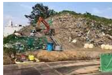
施工状況写真 (H30.5.18)
