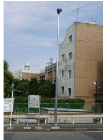
道路照明灯 (一般的)
