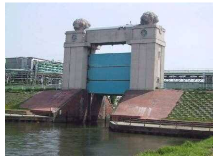
川崎河港水門
