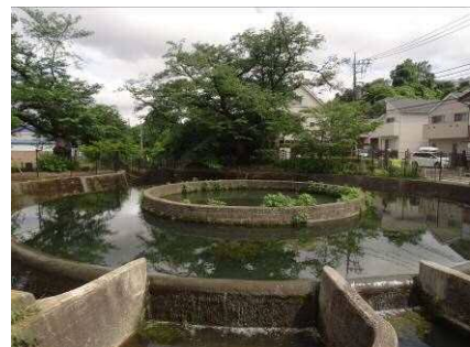
二ヶ領用水久地円筒分水
