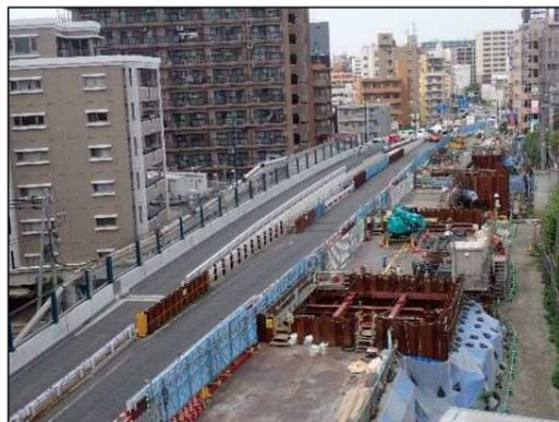
② 1期施工 鋼管杭擁壁、遮音壁完成
