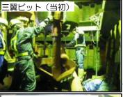
砂質・シルト層の掘削には 適しているが、硬質地盤層を 砕くことが困難
