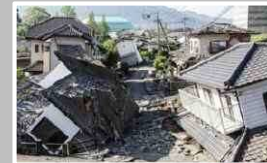
建物倒壊による道路閉塞
