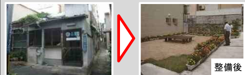
老朽建築物の除却 ⇒ 防災空地の創出
