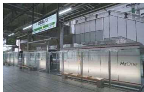
自立型水素エネルギー供給システム (JR武蔵溝ノ口駅)
