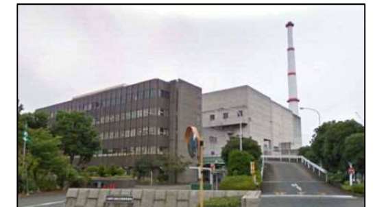
《現在の堤根処理センター》
