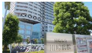
市立川崎病院(川崎区)
