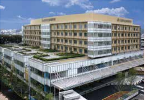
川崎市立多摩病院(多摩区)
