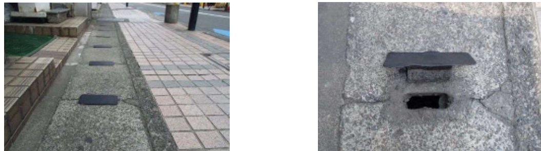
側溝の溝穴を埋めるカバー（使用状況）
