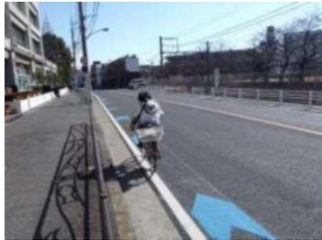
車道左端の路面に青色の矢羽根や、ピクトグラム（進行方向を示す矢印や自転車のマーク等）を設置し、車道上で自転車の通行位置を明示する車道混在の整備
