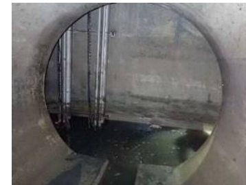
最下流部マンホール
