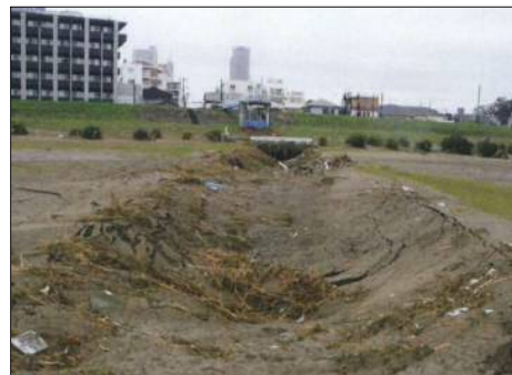
写真:排水樋管周辺状況(台風後)
