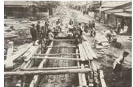
昭和初期の下水管きょの整備
