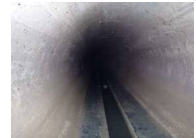
最下流部マンホールから上流
