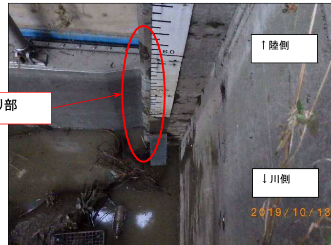
写真:台風後の扉体周辺状況
