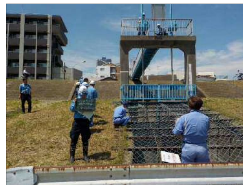
写真: 河川管理者による検査状況
