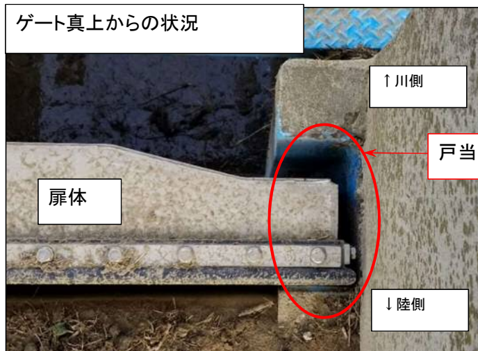
写真:扉体及び戸当り部
