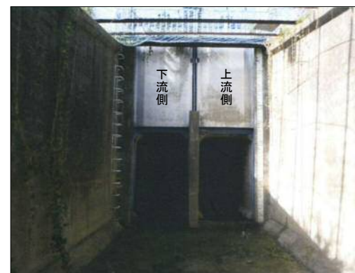
写真: 10月10日点検状況
