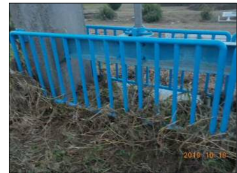
写真:扉体上部状況(台風後)
