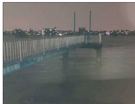
写真:排水樋管周辺状況(当日)
