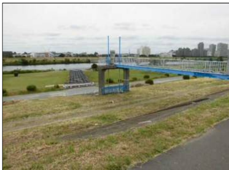
写真:排水樋管周辺状況(平常時)
