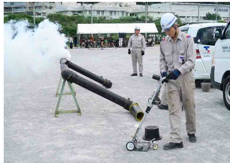
ライフライン応急復旧訓練
