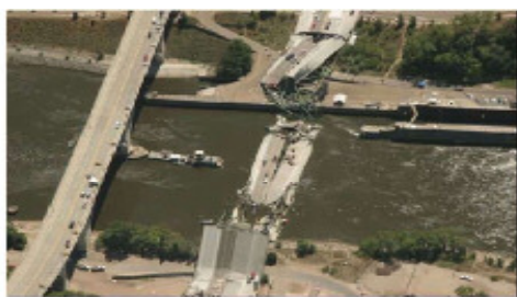
写真1 橋梁崩落事故の状況
