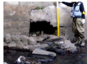
護岸背面部の空洞
