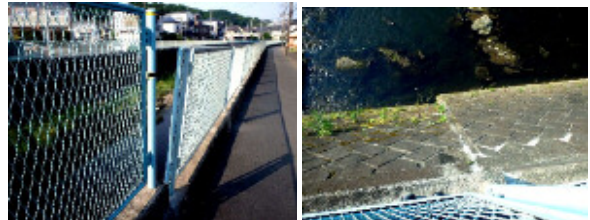
変状による護岸施設の目違い
