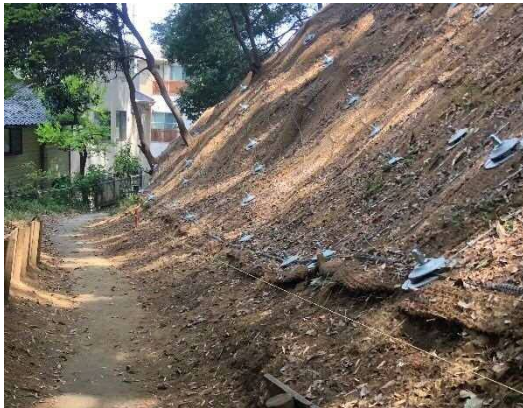
斜面安定整備工事 (菅馬場谷特別緑地保全地区)
