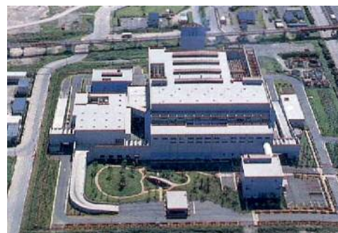
《 完成時 (H7 年) の浮島処理センター 》
