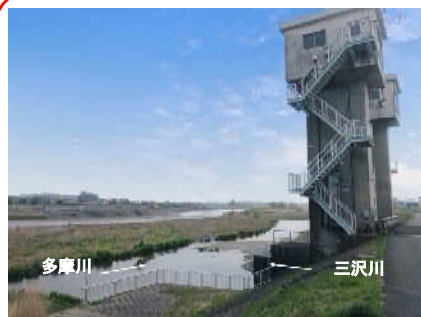
三沢川との合流部
