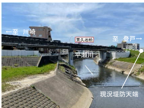
平瀬川との合流部（東久地橋付近）
