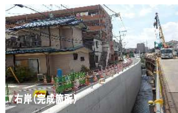
鋼管護岸へ更新中【市費にて対応】
