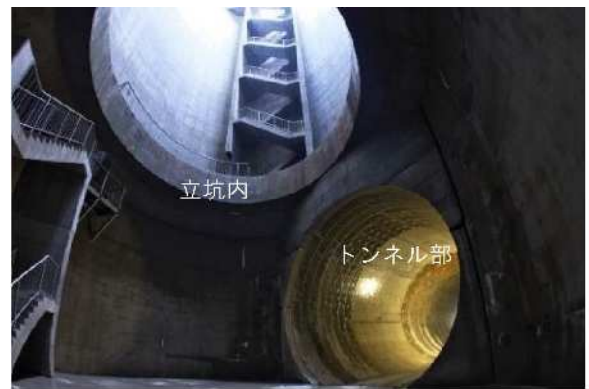
立坑内トンネル
