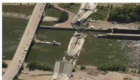
写真1 橋梁崩落事故の状況
