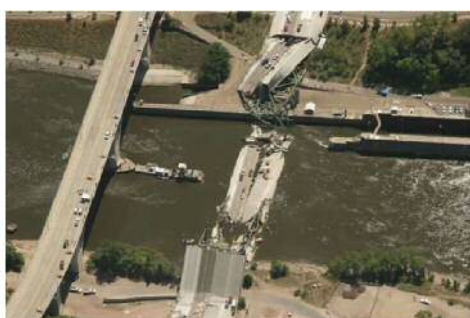
写真1 橋梁崩落事故の状況
