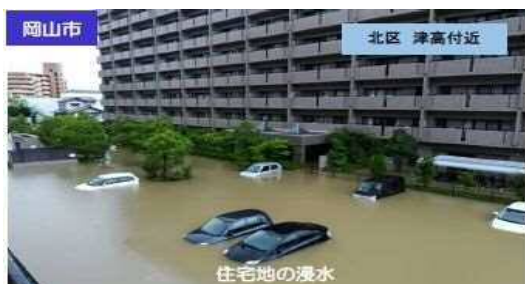
■ 平成30年7月豪雨被害の状況
