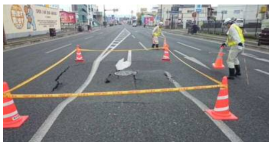
■ 平成28年4月熊本地震被害の状況
