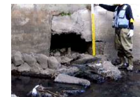
護岸背面部の空洞
