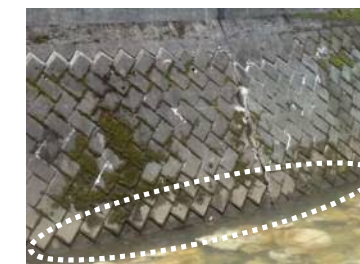
護岸の変状(ブロック隙間の拡大)
