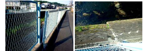
変状による護岸施設の違い
