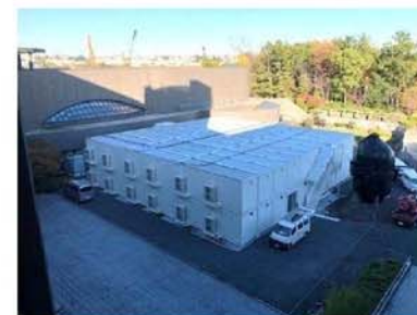
ユニットハウス設置(11/30)
