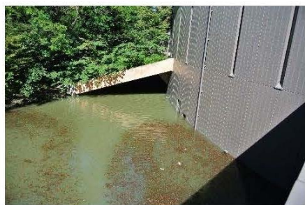
地下駐車場の浸水(10/13)
