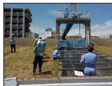
写真: 河川管理者による検査状況
