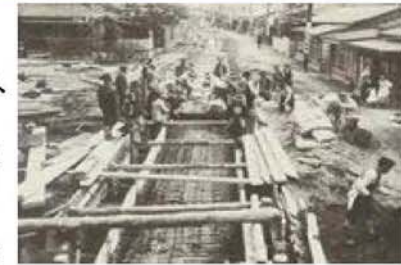
昭和初期の下水管きょの整備
