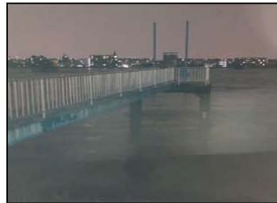
写真: 排水樋管周辺状況 (当時)
