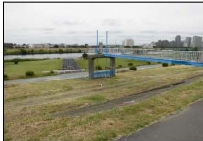
写真: 排水樋管周辺状況 (平常時)
