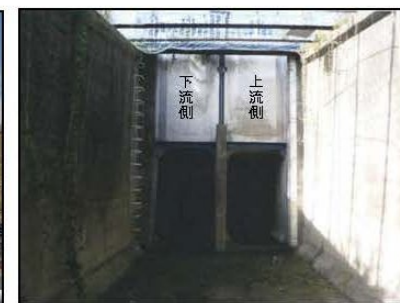
写真: 10月10日点検状況
