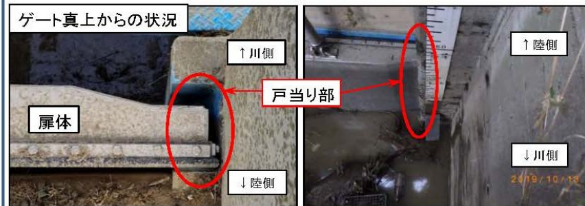
写真: 扉体及び戸当り部
