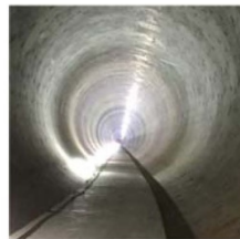
五反田川放水路
