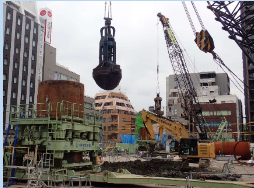
【ハンマーグラブ掘削】
