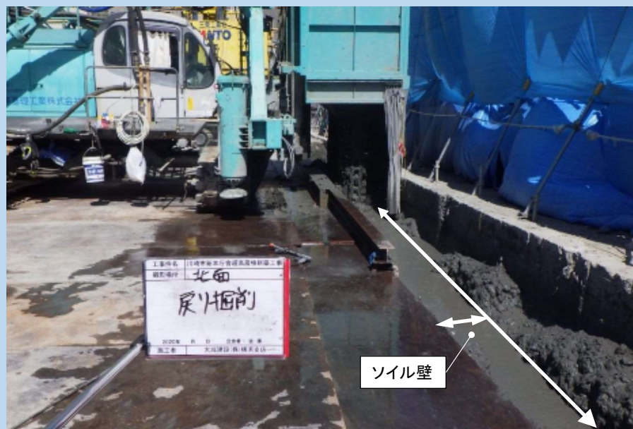
【ソイル壁造成】
