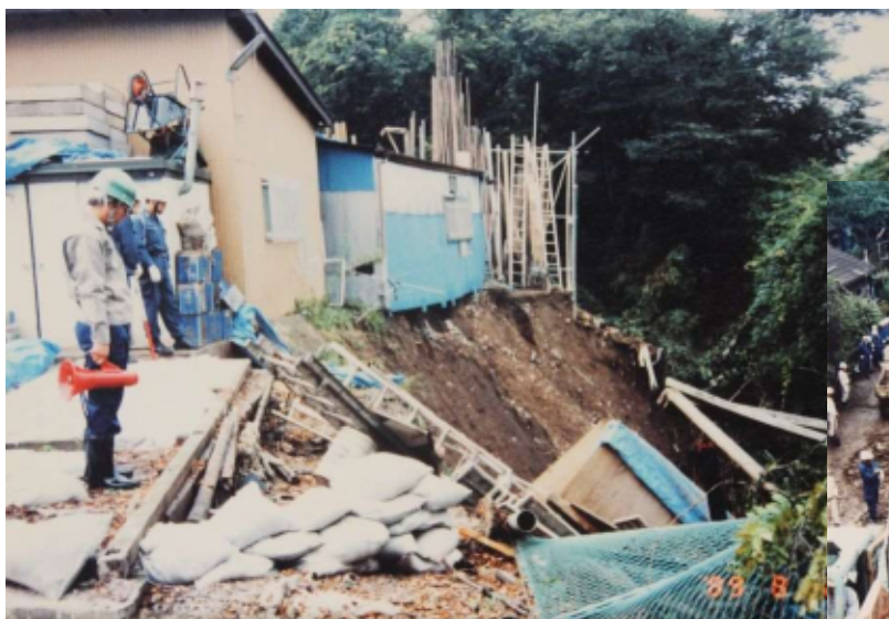
（写真）平成元年蟹ヶ谷崖崩れ災害
