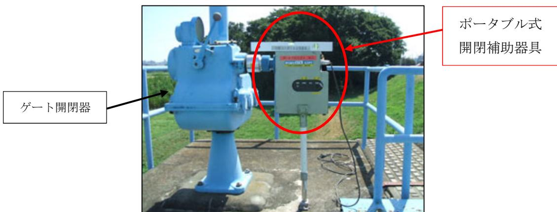
図 12-4-2 開閉補助器具使用のイメージ
