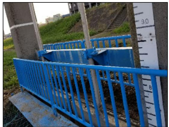
図 12-1-3 排水樋管ゲート室扉体上部の状況
