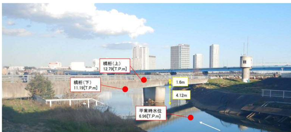
図 6-2-1 橋桁の高さ関係
