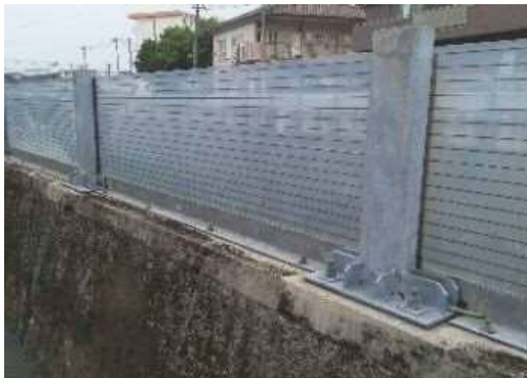
図 7-4-3 アクリル板の補修
