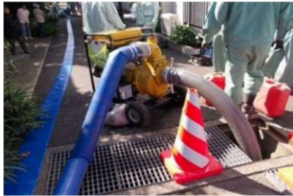
図 7-4-5 移動式ポンプ機(設置事例)
