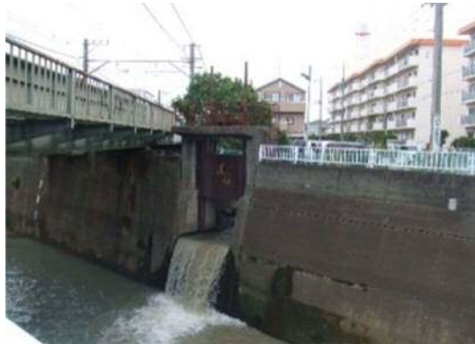
図 7-4-1 大丸用水接続部の水門
