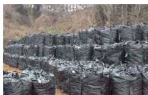
図 6-4-2 土のう設置イメージ
