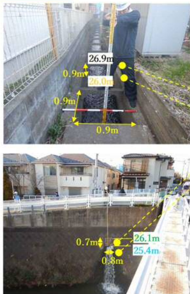
【吐き口部状況写真】
