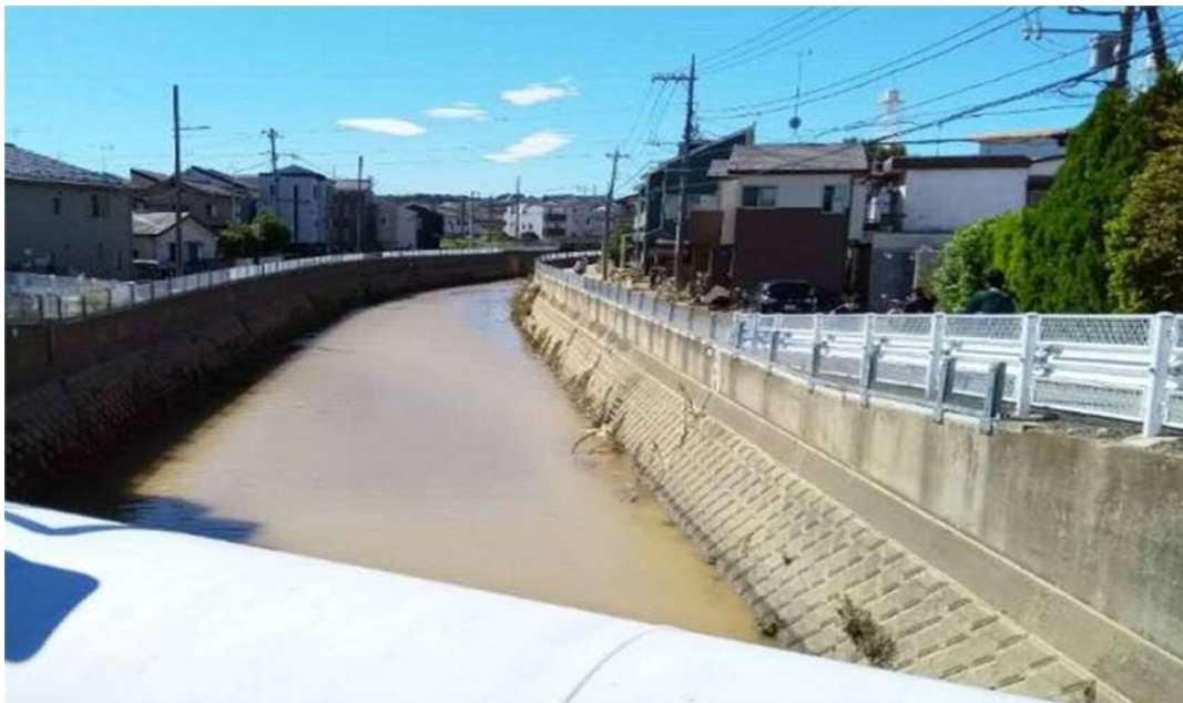
図 4-3-1 三沢川(JR 南武線三沢川橋梁周辺)
