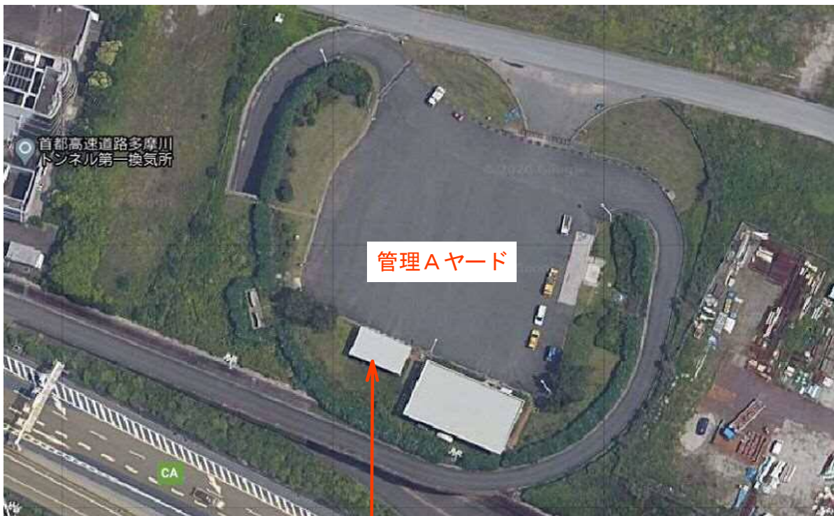
消防用活動車の車庫
