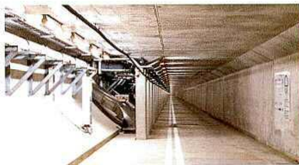
床版下・管理用/非常用通路（待避部）
