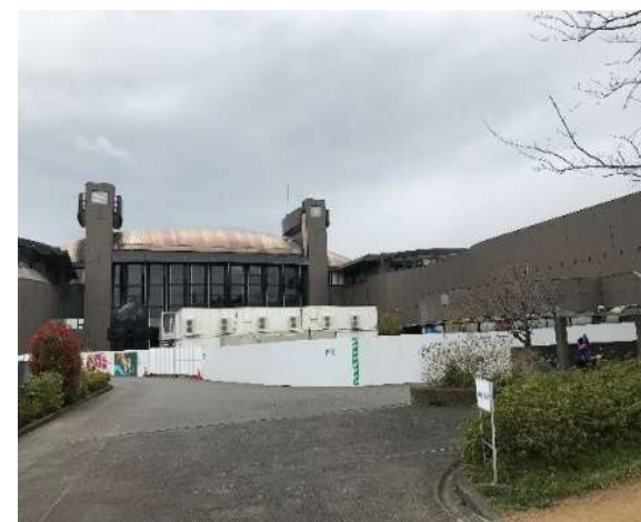
施設前広場の仮囲い
