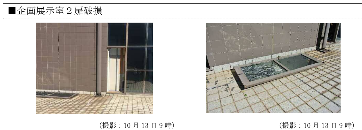
図 10：市民ミュージアム地階以外の被害状況（写真）
