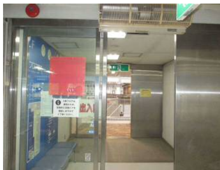
【定期的な換気の実施】
