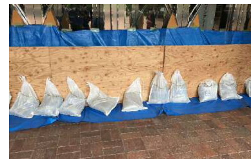
浸水に備え、ドア入口やエレベーター前等へ簡易式止水板を設置する
