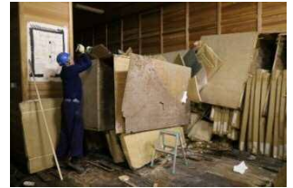
(写真1 第7収蔵庫の被害状況)
