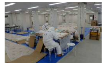
(写真 2 ユニットハウスで剥がし作業)
