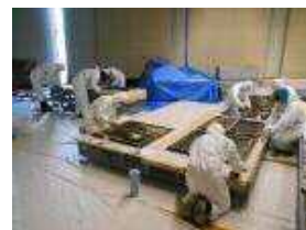
(写真3 写真裏面クリーニング)
