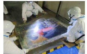
(写真2 アクリル板剥がし)
