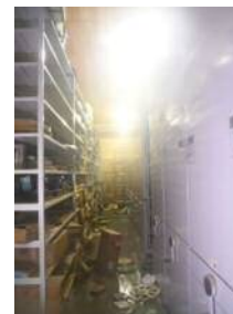
(写真1 第9収蔵庫の被災状況)
