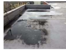
屋上防水の滞水、防水層膨れ
