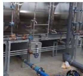
受水槽の給水栓
