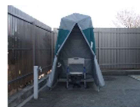
マンホールトイレ
