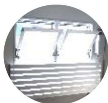
自然開閉換気窓
