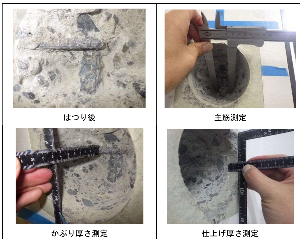
鉄筋腐食度調査
