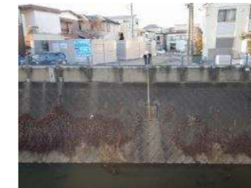
対岸(右岸)から
