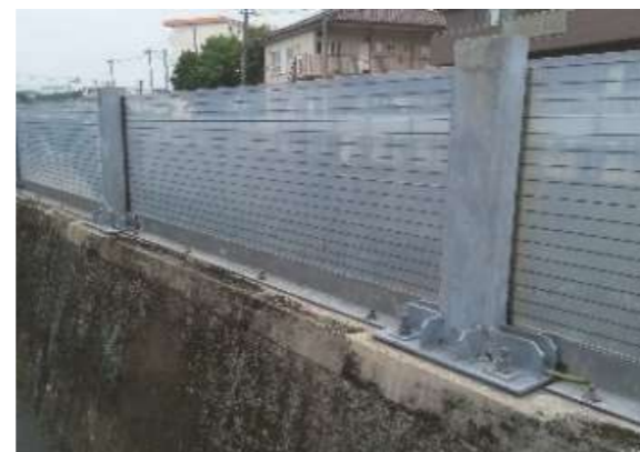
アクリル板の補修
