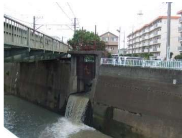
大丸用水接続部の水門
