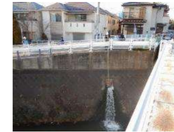
対岸(右岸)から
