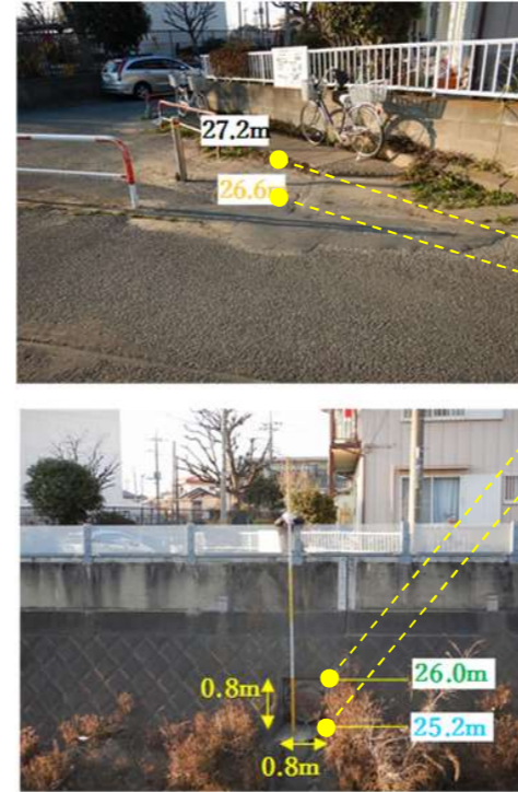
【吐き口部状況写真】
