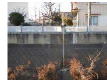
対岸(右岸)から
