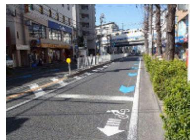
(矢羽根型路面標示と自転車のピクトグラムの設置事例)
