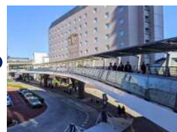
快適な歩行者空間となるペDESTリアンデッキ
