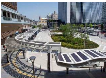
歩車分離の図られた駅前広場
