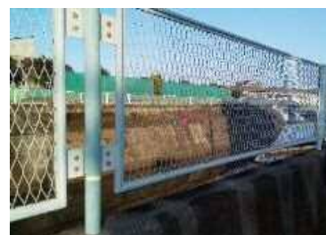
既存パラペット護岸
