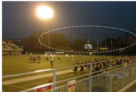
照明範囲のばらつきがみられる。 (奥の電光掲示板周辺が暗い)
