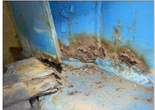
写真6-7 鋼桁の亀裂・腐食
