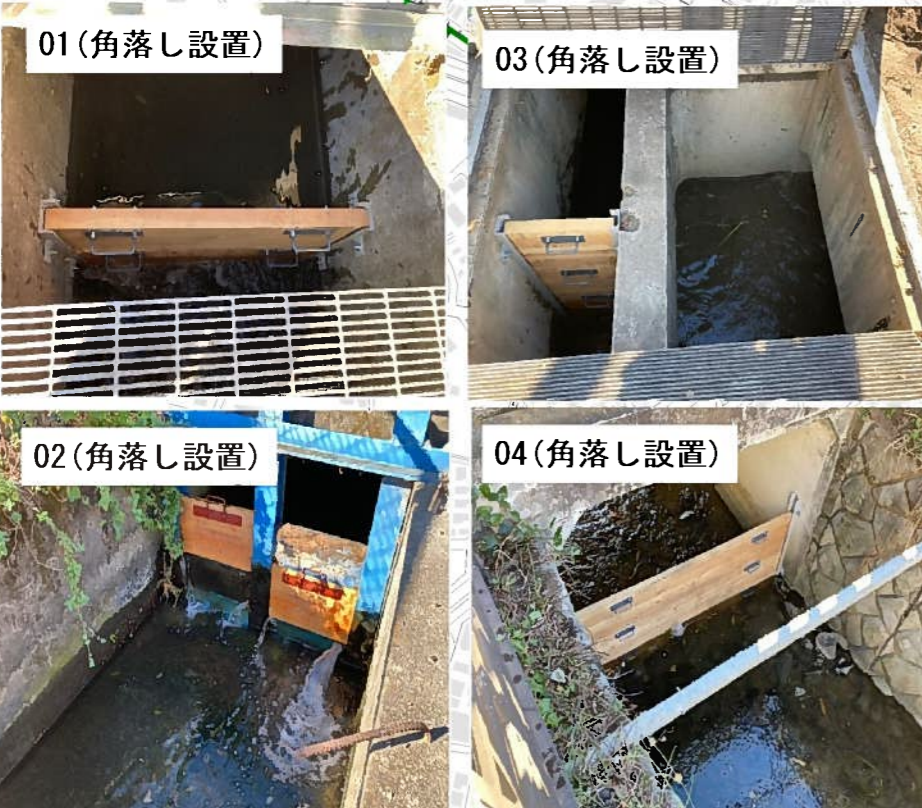
角落し設置状況
