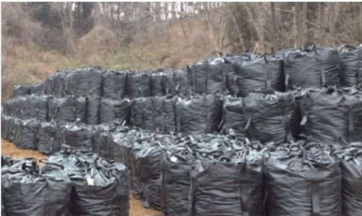
大型土のう（設置事例）
