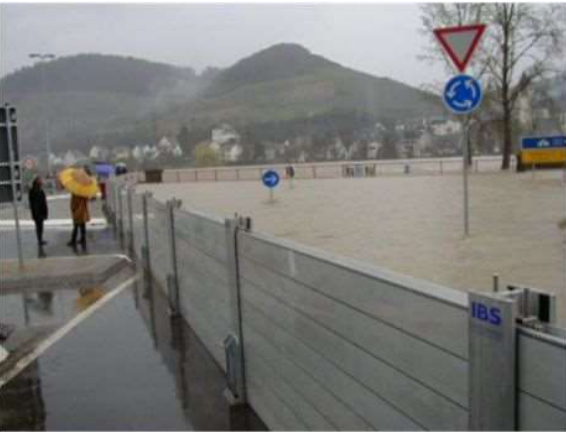
防水壁（設置事例）
