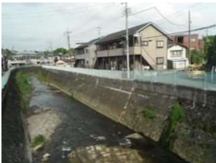
整備後の平瀬川
