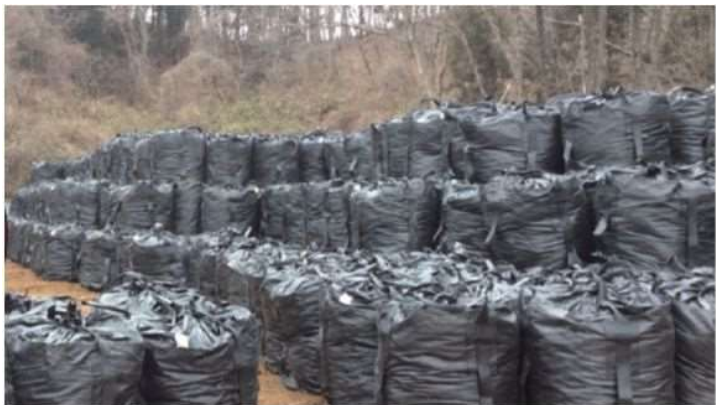
大型土のう（設置事例）
