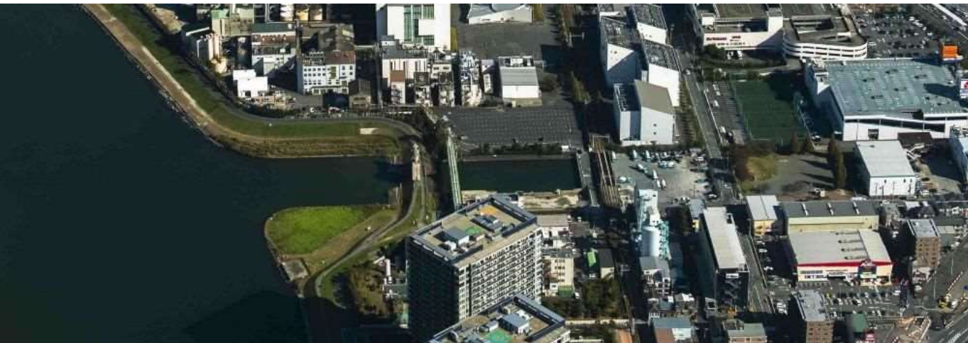
河港水門航空写真
