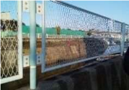
既存パラペット護岸
