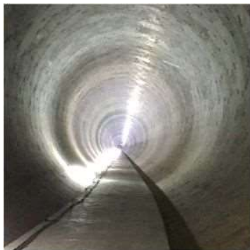
五反田川放水路
